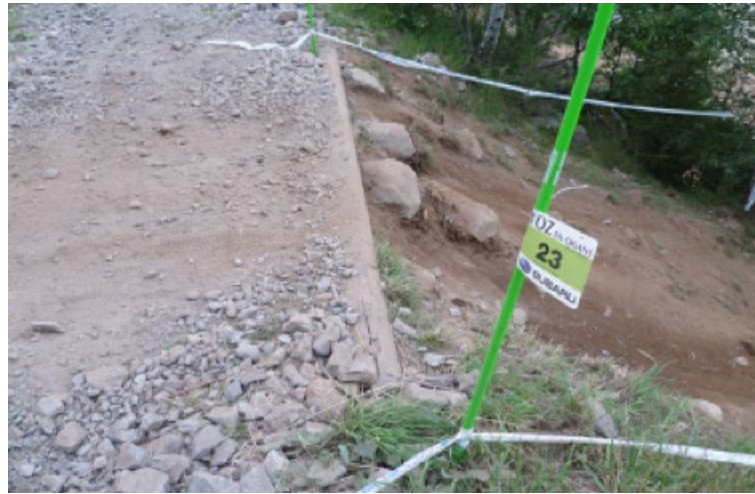
Mise en place d'un rondin de bois sur les zones de freinage pour retenir le talus
