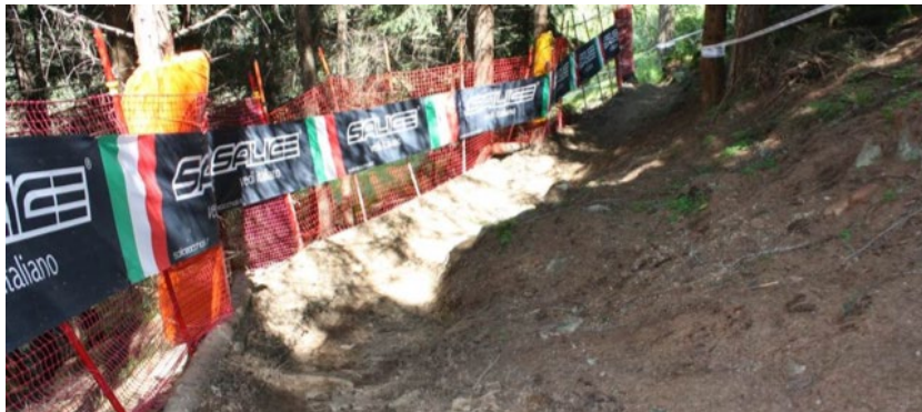
Filets de protection avec banderole non tissée placée à hauteur de guidon (ou bache)
