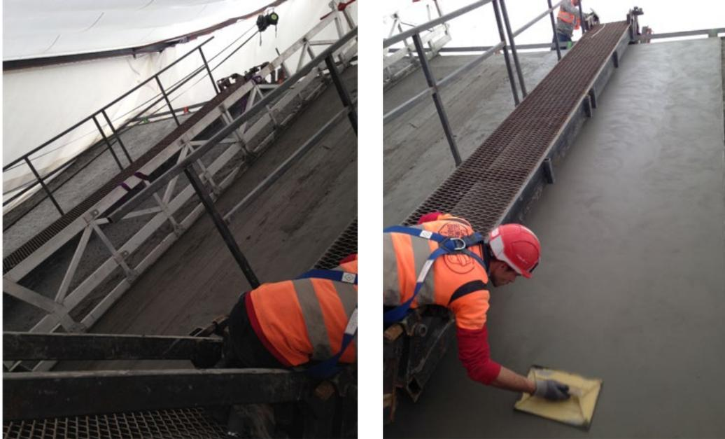
Il est nécessaire de disposer des joints afin de réduire les tensions dans le béton et éviter ainsi la dilatation et donc la formation de fissures à la surface.
