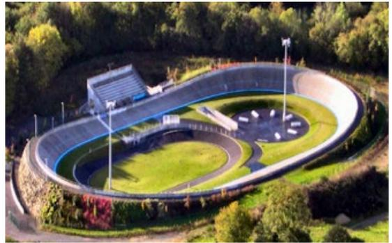
De la qualité du remblai et notamment de son compactage dépend en effet la longévité et la qualité de la piste. Mal compacté, le remblai risque de se tasser provoquant fissures et affaissements.
