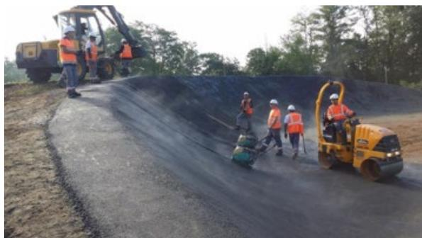
Cette solution a un coût et nécessite une réelle expertise en la matière. Le choix de la granulométrie (0/6 ou 0/10), la quantité et la qualité du liant mais surtout la procédure de mise en œuvre conditionneront la réussite de cette opération (éviter un compactage par cylindrage perpendiculaire sous peine de créer des rainures et le ratissage qui tendra à faire ressortir le grain lors du séchage)
